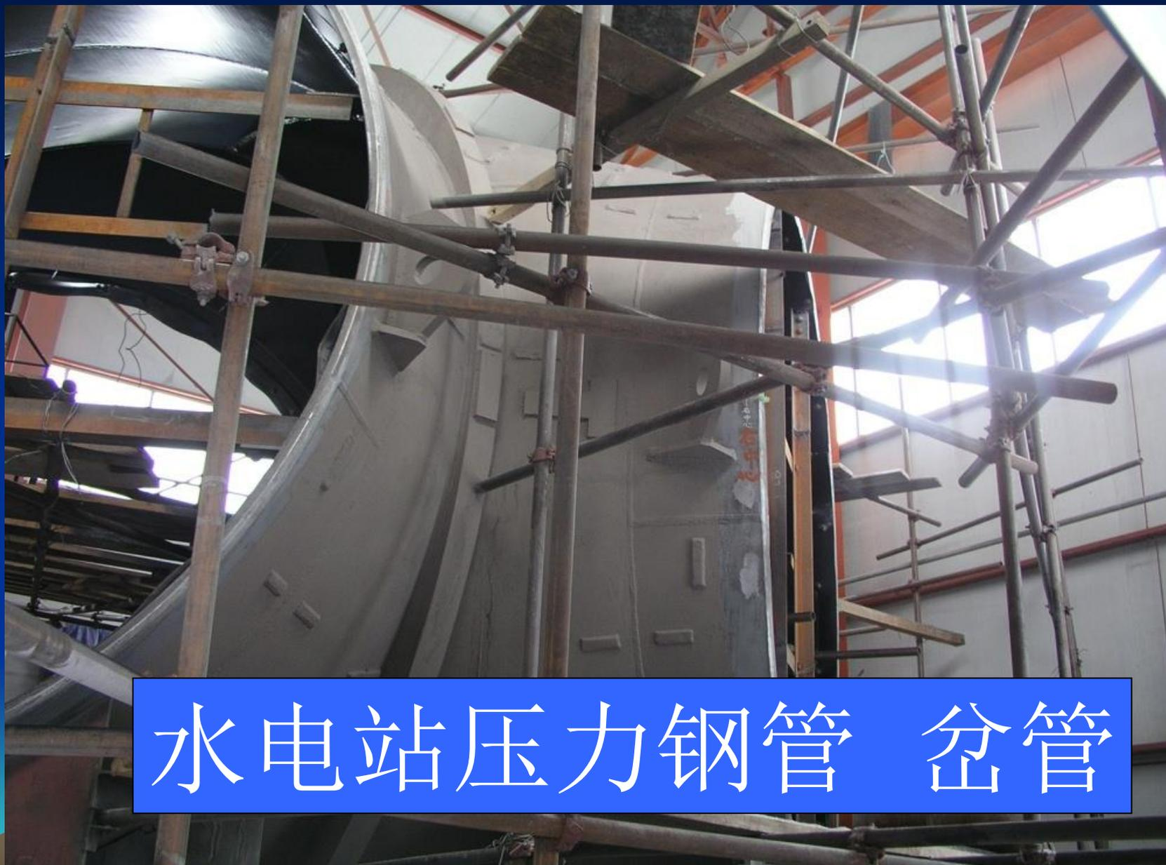
水电站压力钢管 岔管
