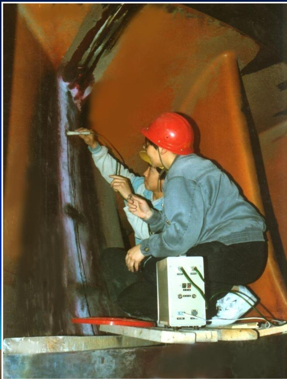
转轮在工厂制造成两个1 / 2，然后到现场对焊成整体转轮。
